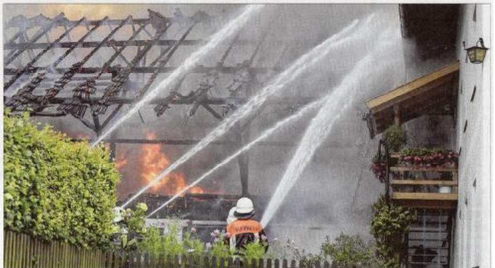
Die Löschmannschaften konzentrierten sich deshalb darauf, das Wohnhaus vor den Flammen zu schützen und ein Übergreifen auf benachbarte Gebäude zu verhindern. Durch den massiven Löscheinatz der Feuerwehren gelang dies auch. (Foto: FDL/Kirchhof)
